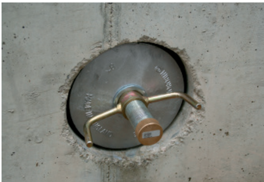
Aqua Stopper als Verschluss von Kernbohrungen
